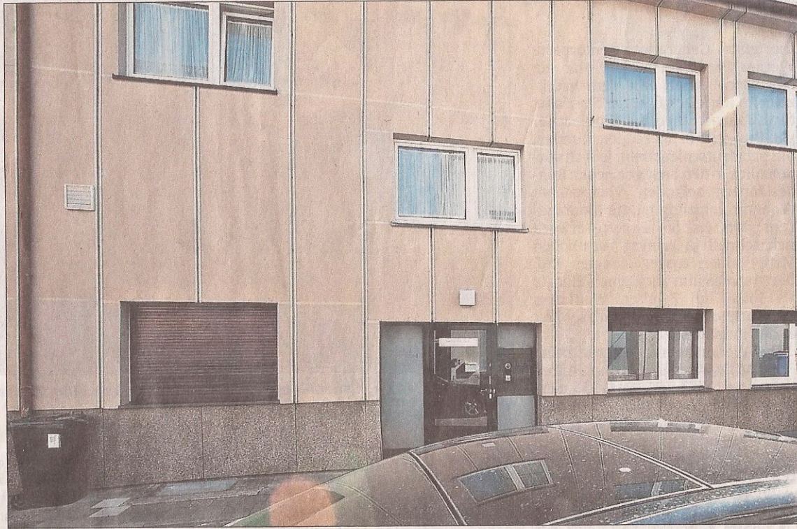
Rechts und links neben der Eingangstür hat ein Unbekannter am Gebäude der Jüdischen Kultusgemeinde zwei Hakenkreuze und antisemitische Sprüche in die Fassade geritzt.
